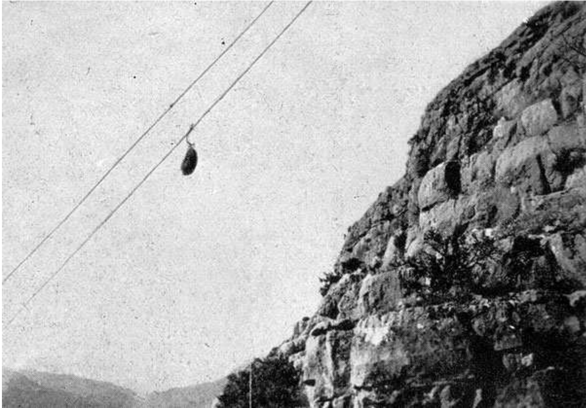
Abb. 14. Steigung am Zastrmhang zwischen V und VI.
