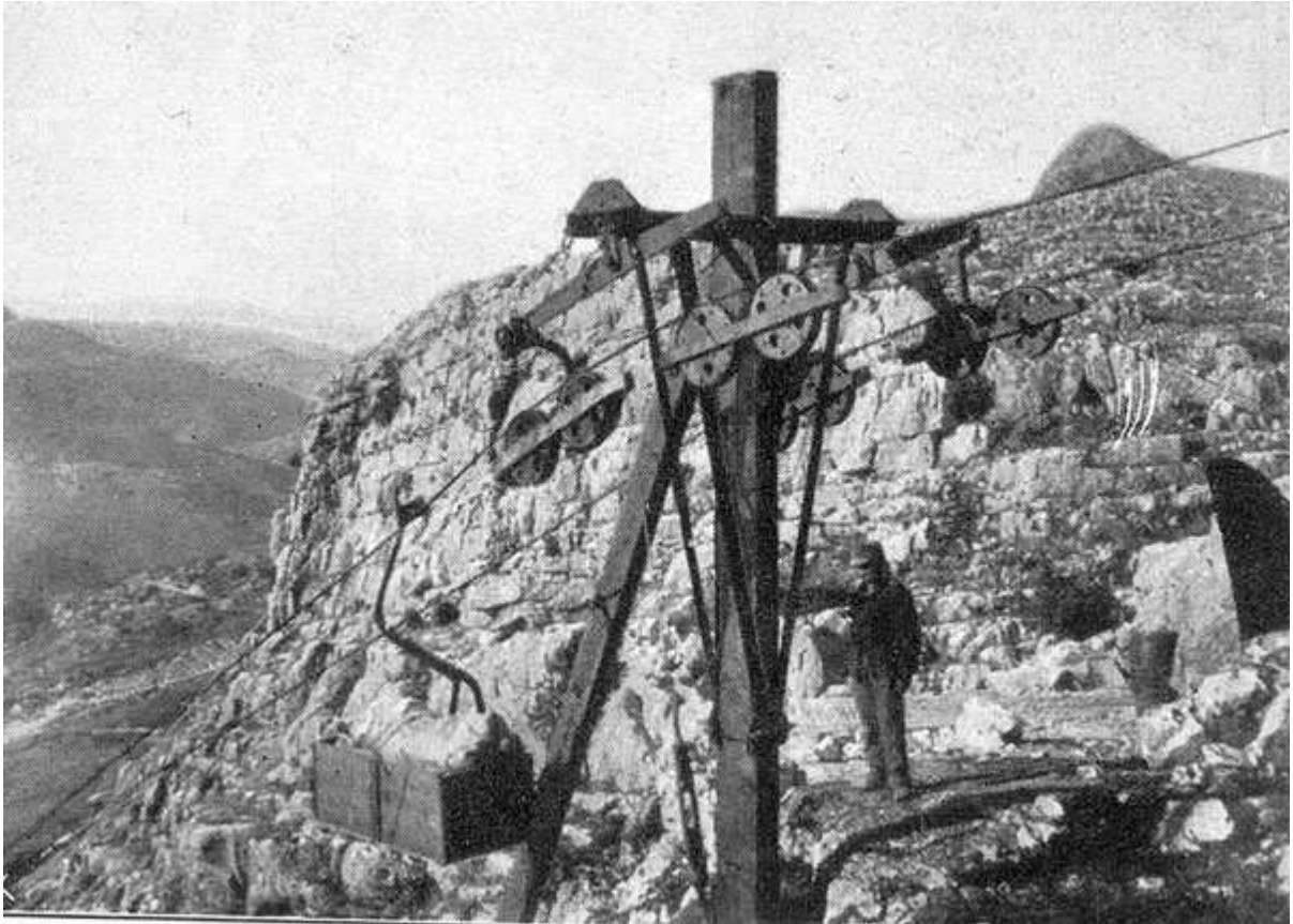
Abb. 9. Mast VI mit Doppel-Tragrollenpaar
