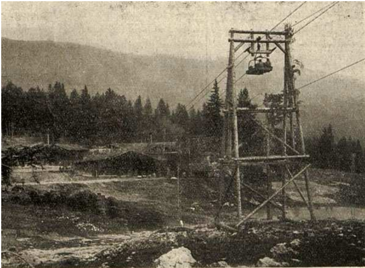
Lichtbild 2 (Station und Portalstütze einer Zweiseilbahn mit Umlaufbetrieb).
