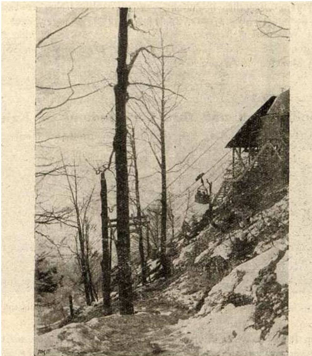
Lichtbild 5: Bergstation einer steilen zweispurigen Zweiseil-Pendelbahn.
